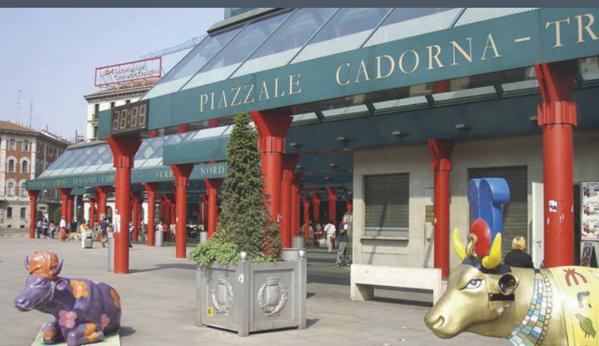
Realizzazione pilastri e sostegno pensilina per P.zza Cadorna, Milano.
